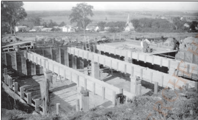
Fondation Henry Buzzell, Société d'histoire des Quatre Lieux La construction du réservoir d'eau potable du village chez Herbert Buzzell en 1924.
