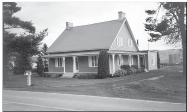
Maison rénovée en 2002, au 81, rang Saint-Ours.
