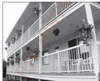
Balcon de la Résidence du Verger.
